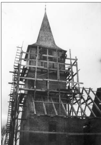
Spiret er ved at være færdigt
