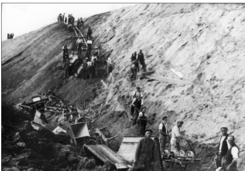
På et tidspunkt under udgravningen skred en tipvogsbane
