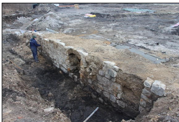
Udgravning af Støvring Vandmølle
