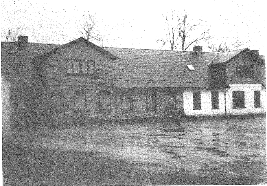
Arestrup gamle skole
