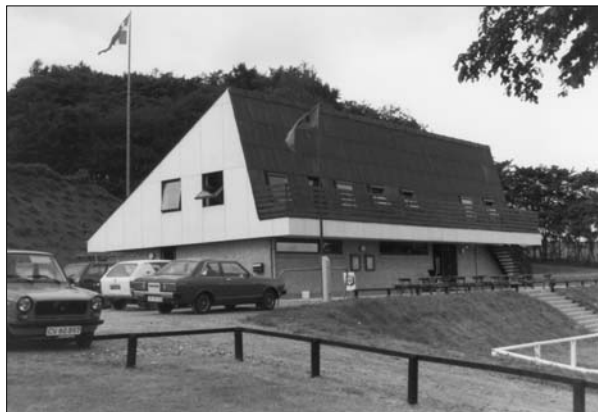
Klubhuset bygget i 1978
