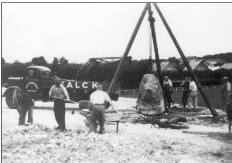
Stenen placeres ved den ny håndboldbane
