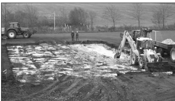
Udgravning til multibanen – i silende regn
