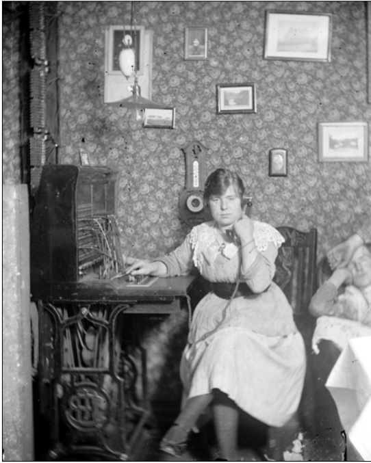
Emmy ved telefoncentralen
