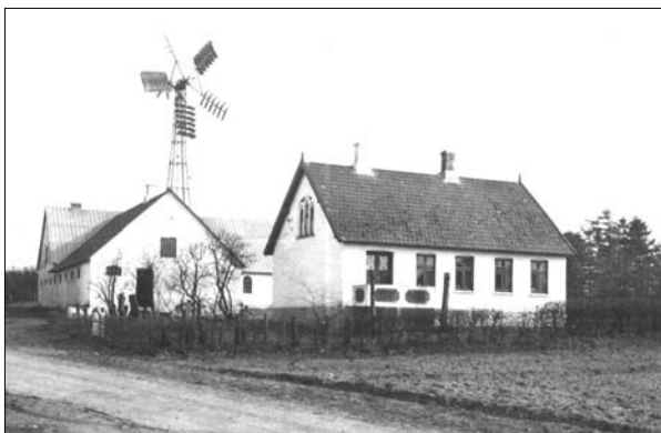
Klapsejler på Øster Hornumvej 14
