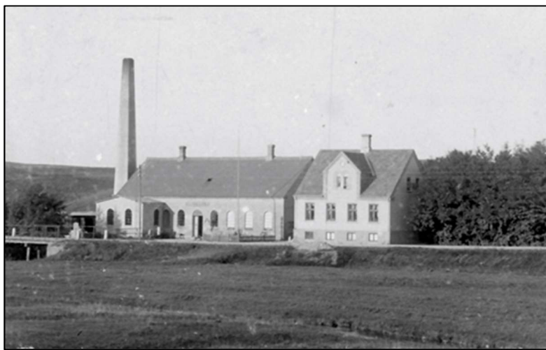
Elinelund Andelsmejeri ca. 1900 med bestyrerbolig til højre
