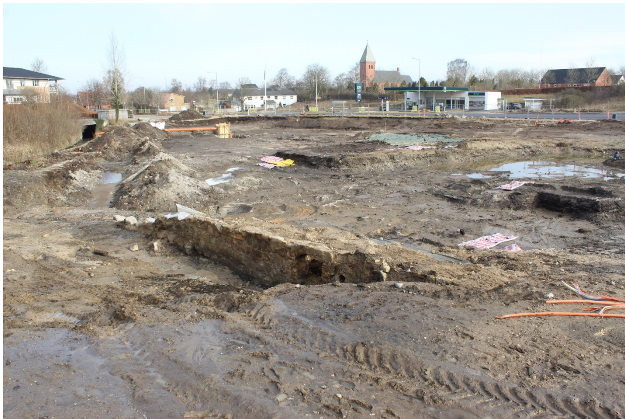
Fig. 1. Udgravningsområdet i slutningen af februar 2021. I forgrunden er den østlige mur til 17-1800-tallets stampemølle ved at dukke frem. Mastrup Bæk løber neden for træerne til venstre i billedet. I baggrunden anes Hobrovej og Støvring Kirke. Foto: NHM.
