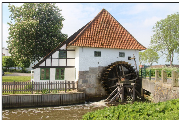
Underfaldshjul på Slotsmøllen i Aabenraa
