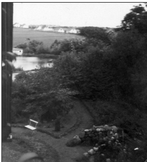
Til venstre i billedet skimtes bygningen, der rummede turbinen og generatoren
