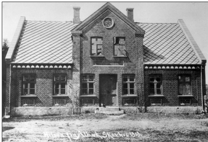
Kort efter Ottolines tid blev det gamle Albæk Skovhus erstattet af et grundmuret hus
