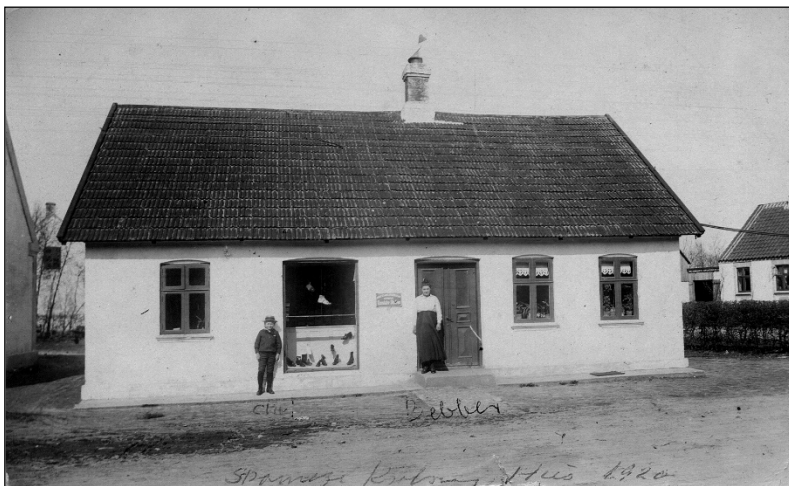
Suldrup fik sin telefoncentral indrettet hos skomager Krab-sen på hjørnet af Veggerbyvej og Hjedsbækvej
