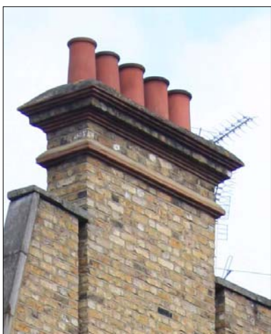
Skorsten med 5 rør
